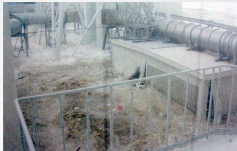
<図1>15:43の福島第一原発4号機 南側付近の様子
