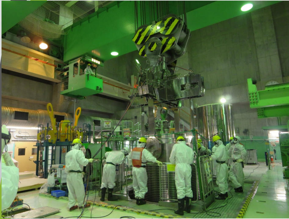
<図4>福島第一原発4号機燃料棒 取り出し作業中の様子
