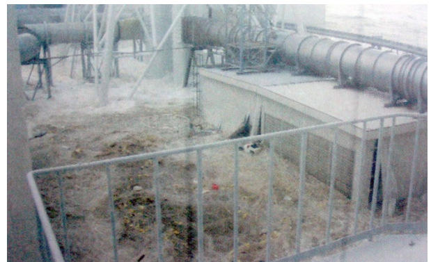
<図2>15:43の福島第一原発4号機南側付近の様子
