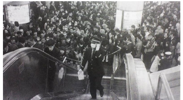
計画停電による間引き運転の影響で吉兆自駅構内は利用客で溢れ、駅員は対応に追われた＝2011年3月14日朝日新聞夕刊3面
